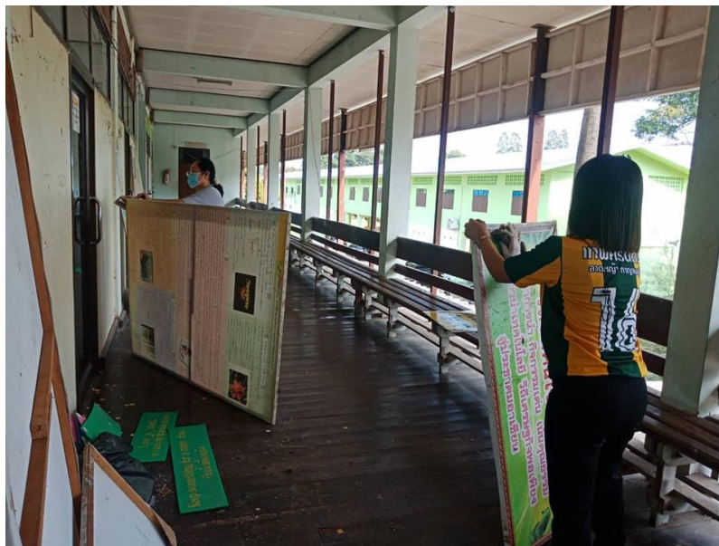
ปรับปรุงภูมิทัศน์ (Renovate) อาคาร 1 (หลวงพ่อลำไย)
